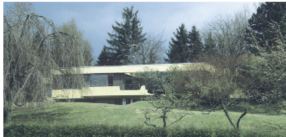
Die Villa Wagner in Spaltenstein bei Friedrichshafen am Bodensee.
